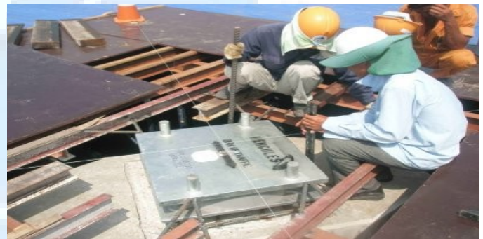
Dự án thay gối cầu, khe co giãn cầu Non Nước
