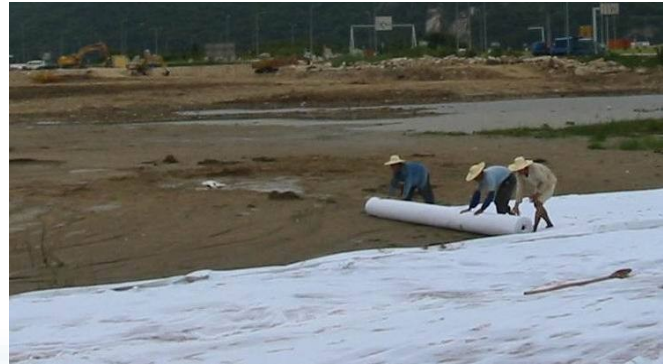
Dự án Thượng Mỹ Trung - Tỉnh Quảng Bình
