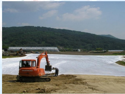
Dài vải địa kỹ thuật lên
