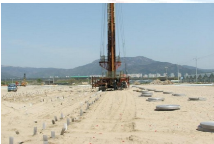
Cắm bắc thấm
